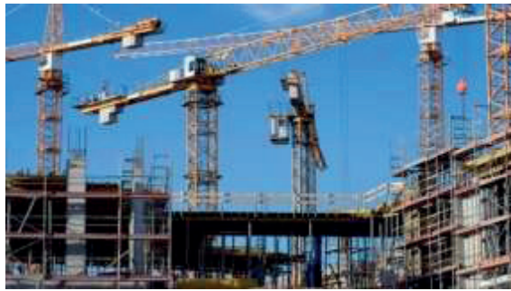
Görsel 1.34: Kaldırma aracı-kule vinç
