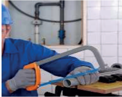
Görsel 1.44: Sıhhi tesisatta çalışma
